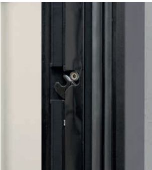
Der Verschluss mit pferdekopfförmiger Verriegelung im Rahmen
